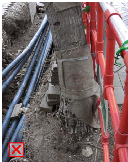
照片 9 — 在樹木保護範圍內進行挖掘，會對根系造成嚴重損害
