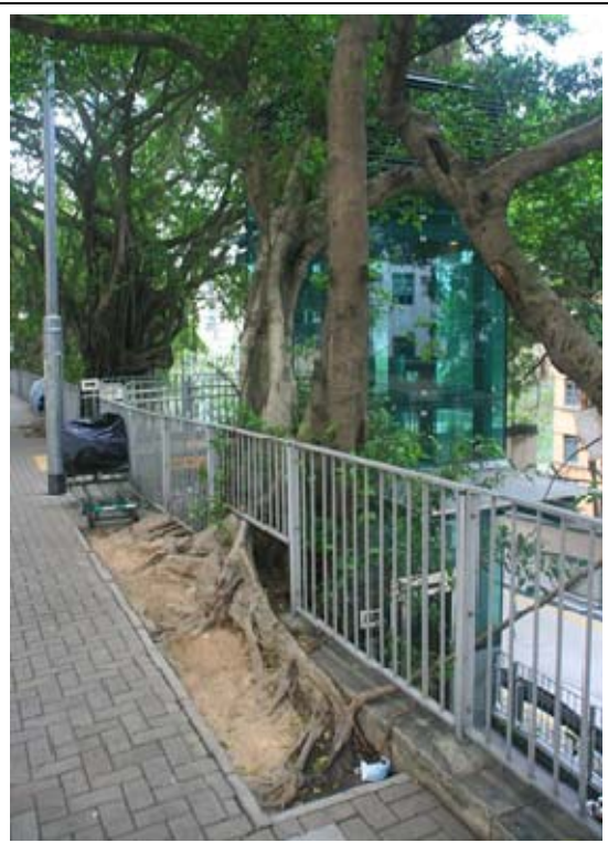
相片7 — 在擋土牆頂部提供根部伸展範圍
