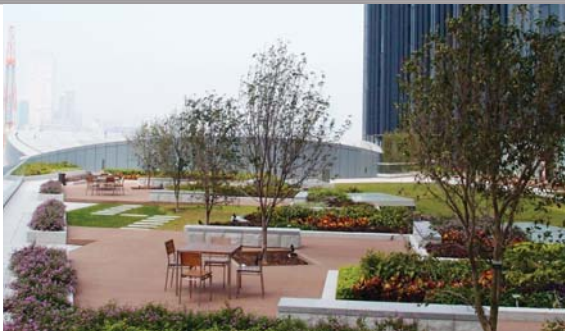
位於立法會綜合大樓的屋頂綠化 Green roof at Legislative Council complex
