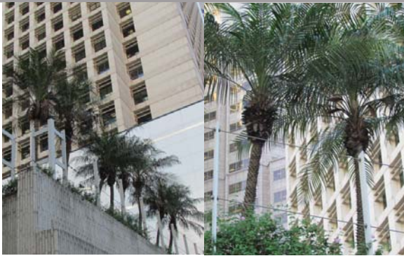
位於中環的密集型屋頂綠化 Intensive green roof at Central
