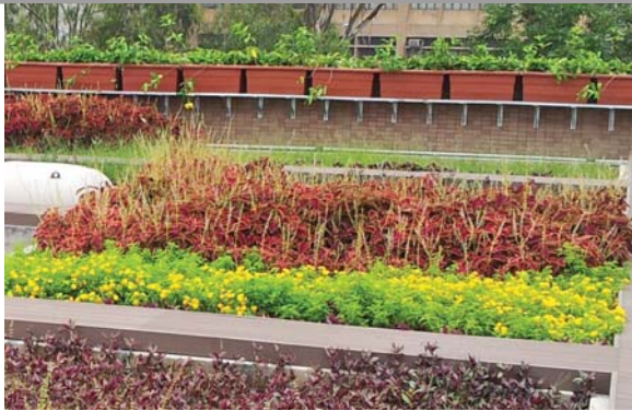
位於舊墟污水泵房的屋頂綠化 Green roof at Kau Hui Pumping Station
