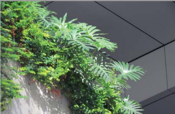
位於添馬公園的有蓋平台花園 Podium planting under covered area at Tamar Park
