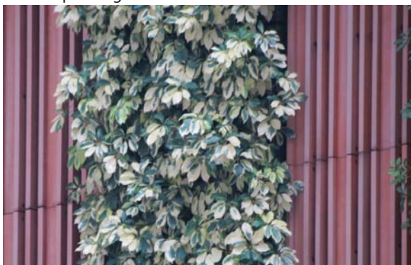
位於荃灣荃新天地的垂直綠化 Vertical greening at City Walk, Tsuen Wan
