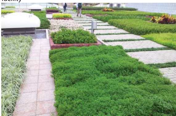
位於沙田污水處理廠的屋頂綠化 Green roof at Sha Tin Sewage Treatment Works
