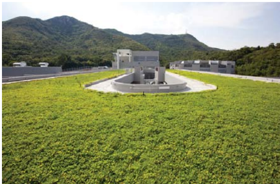
位於羅湖懲教所的屋頂綠化 Green roof at Lo Wu Correctional Institution
