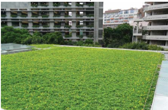
位於鑽石山火葬場的粗放型屋頂綠化 Extensive green roof at Diamond Hill Crematorium
