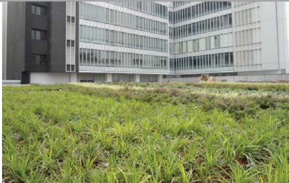
位於西貢將軍澳政府綜合大樓的粗放型屋頂綠化 Extensive green roof at Sai Kung Tseung Kwan O Government Complex
