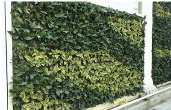
位於屯門公路隔音屏障上的垂直綠化 Vertical greening on noise barriers at Tuen Mun Road
