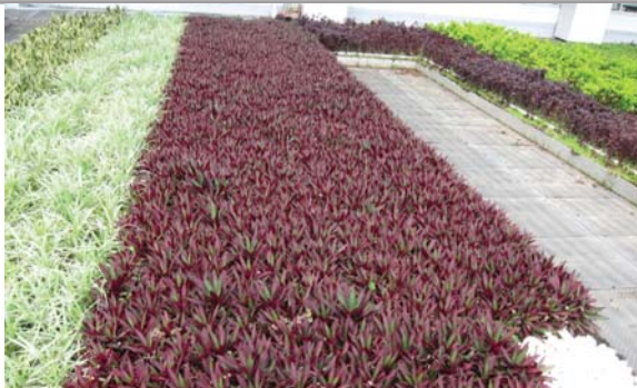
位於西貢將軍澳政府綜合大樓的粗放型屋頂綠化 Extensive green roof at Sai Kung Tseung Kwan O Government Complex
