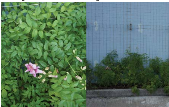
位於土瓜灣基本污水處理廠的垂直綠化 Vertical greening at To Kwa Wan Preliminary Treatment Works
