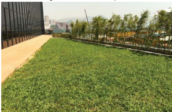
位於添馬立法會綜合大樓的粗放型屋頂綠化 Extensive green roof of Legislative Council Complex
