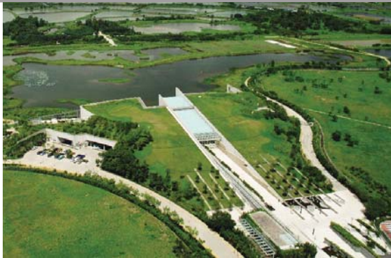
位於香港濕地公園訪客中心的粗放型屋頂綠化 Extensive green roof on Hong Kong Wetland Park Visitor Centre
