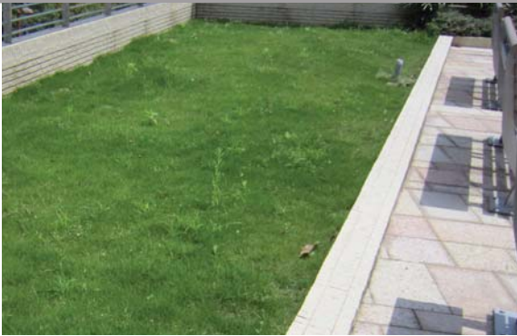
位於歌連臣角火葬場的粗放型屋頂綠化 Extensive green roof at Cape Collinson Crematorium
