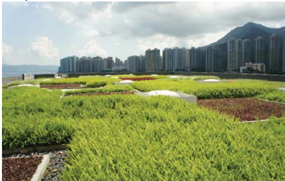
位於沙田污水處理廠的粗放型屋頂綠化 Extensive green roof at Sha Tin Sewage Treatment Works
