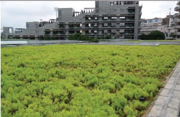
位於鑽石山火葬場的粗放型屋頂綠化 Extensive green roof at Diamond Hill Crematorium
