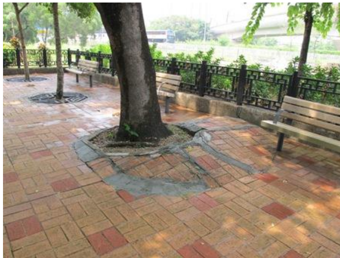
圖 2 樹根生長旺盛，掀起行人路的路面
