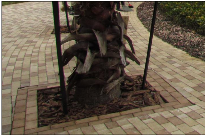
圖 9 在泥沙底層上鋪砌透水的鋪路磚
