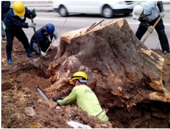
相片11 正在移除樹樁
