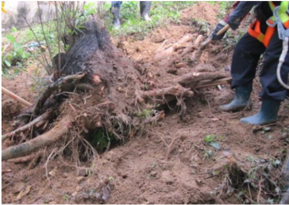
相片1 以人手挖掘移除樹樁
