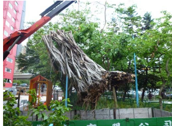
相片2 以機器吊走樹樁
