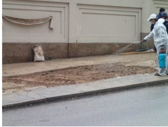
相片15 花槽重新填上新泥土
