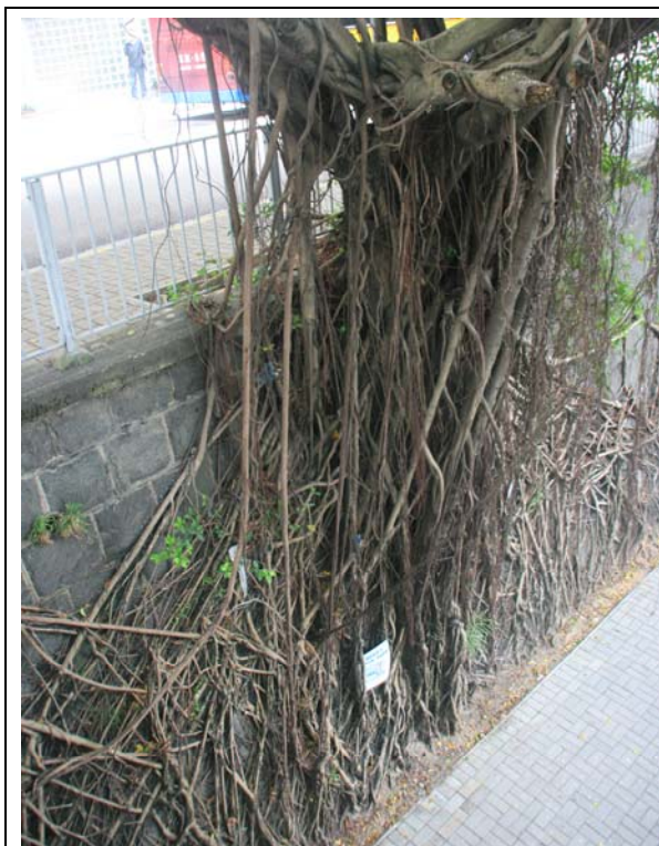
相片6 — 在擋土牆基部提供根部伸展範圍
